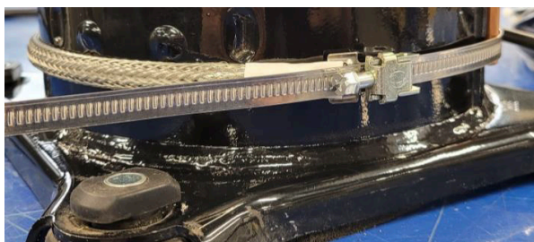
Zdjęcia z prawidłowo ułożoną grzałką karteru sprężarki.
