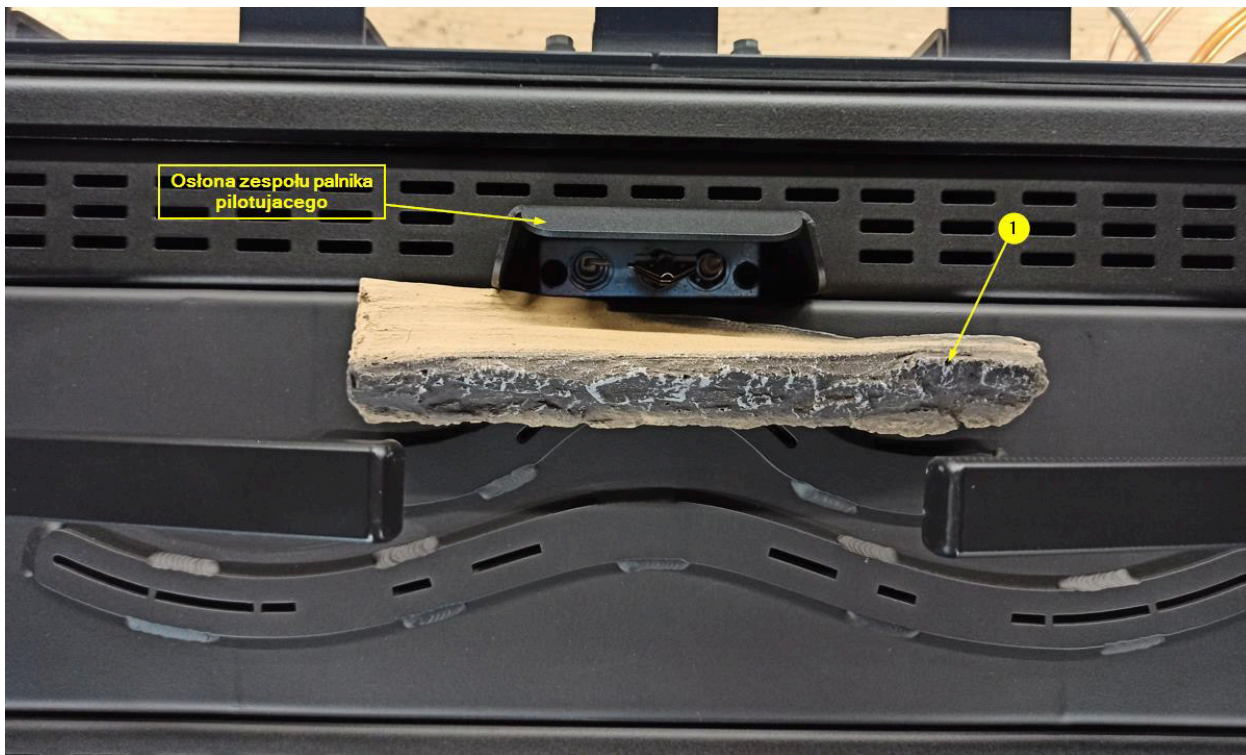
Rys. 5. Ułożenie drewna ceramicznego numer 1 (widok z góry).
